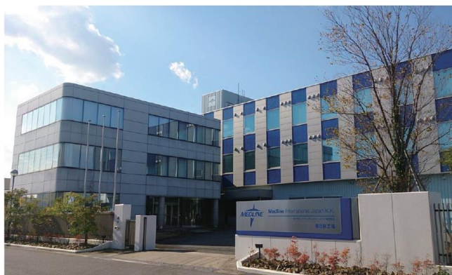
春日井工場 外観
